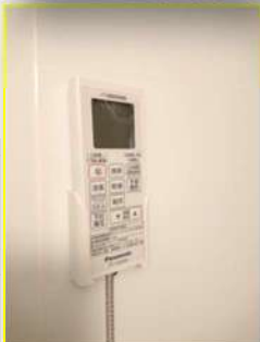
浴室乾燥換気扇
