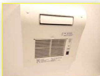
浴室乾燥換気扇
