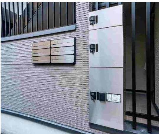
ご不在の時も配達可能な宅配BOX設置。
