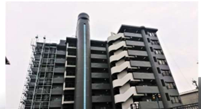
※外壁施工中写真
