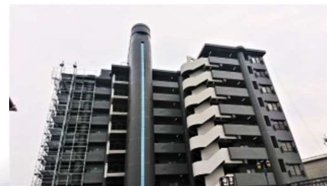
※外壁施工中写真
